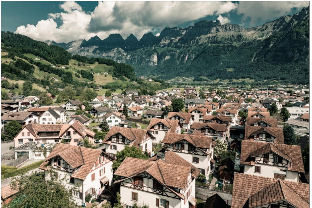
Foto 1: Die denkmalgeschützte Arbeitersiedlung Neudorf besteht aus 49 Wohneinheiten (Foto: Thomas Kessler)
